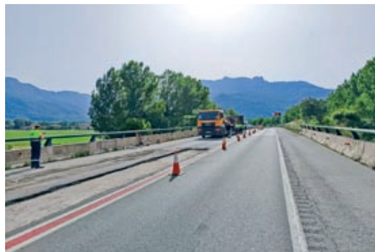
La C-37, tallada divendres a Torelló. A baix, obres de reparació a Joanetes
