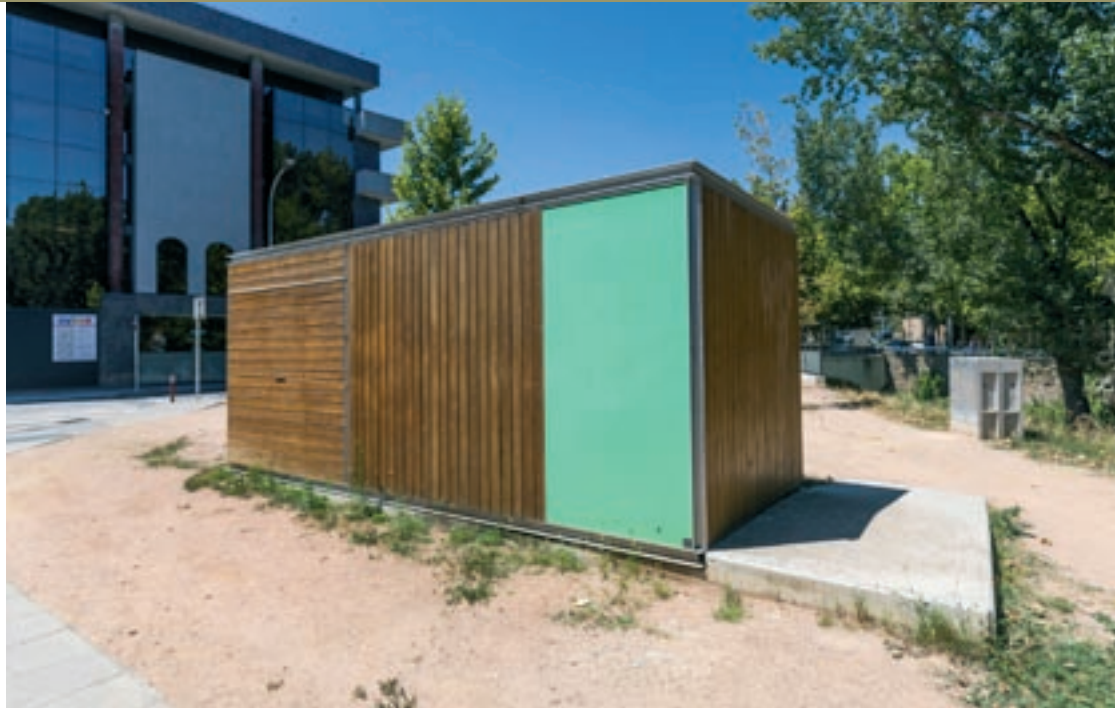
La caseta de fusta del solar que va quedar lliure quan es va enderrocar l'antiga gasolinera
