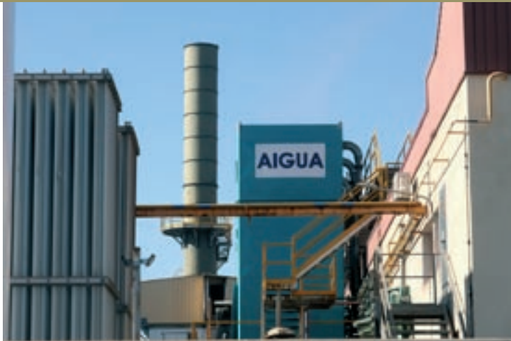
La xemeneia que Befesa va instal·lar sense llicència municipal
