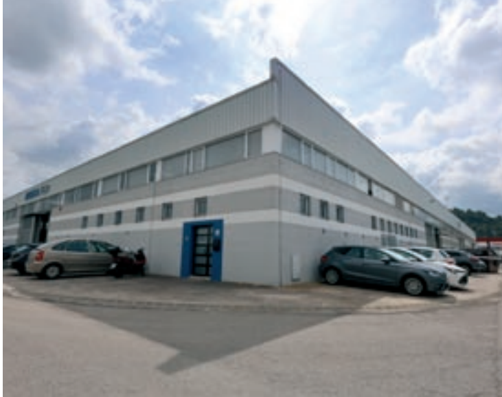
Instal·lacions de Rotatek al polígon industrial Roca de Martorelles
