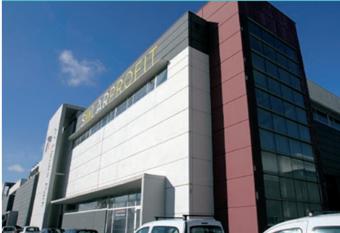
Instal·lacions de SolarProfit a Llinars
