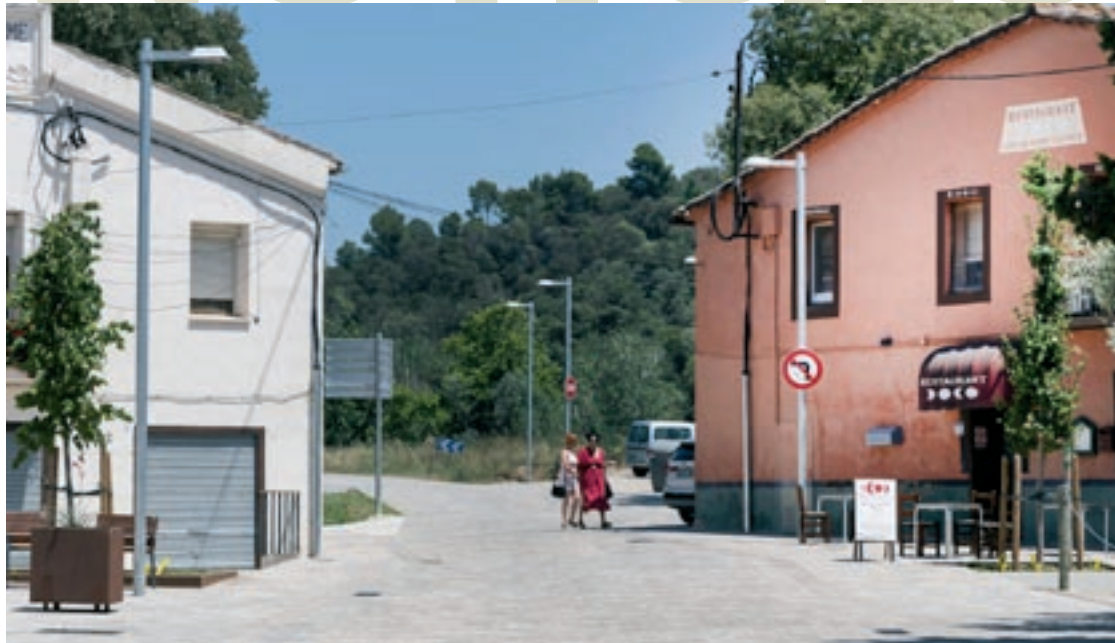
Tram final de la nova plataforma, amb paviment rugós de dos colors
