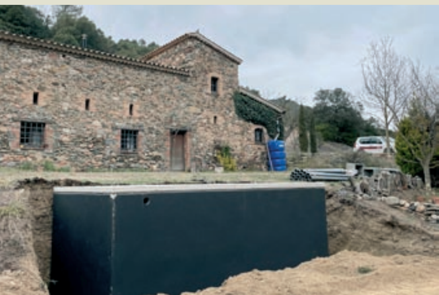
Ha instal·lat a la Casanova de Sant Miquel, a Aiguafreda, durant els treballs d'instal·lació
