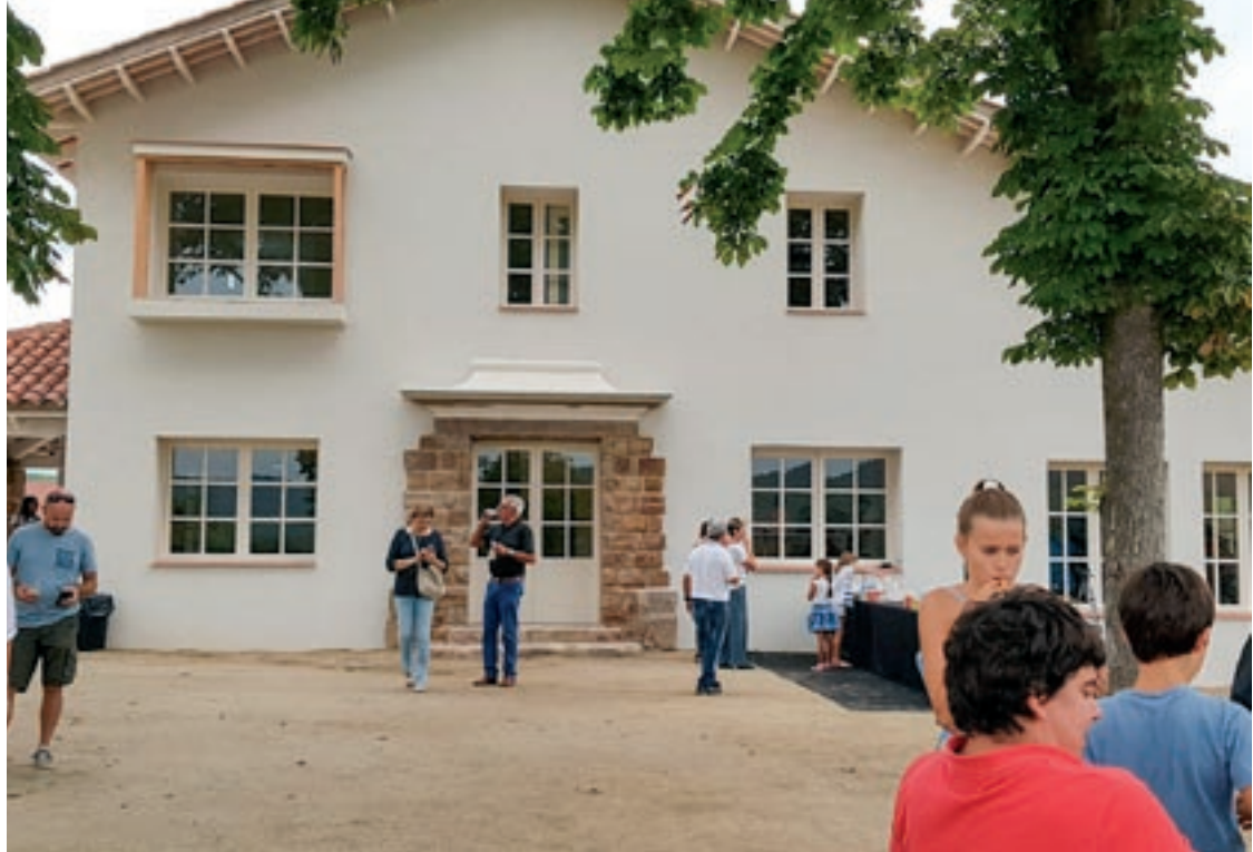
L'escola de música de Llinars és un dels edificis que ja fan servir calderes de biomassa
