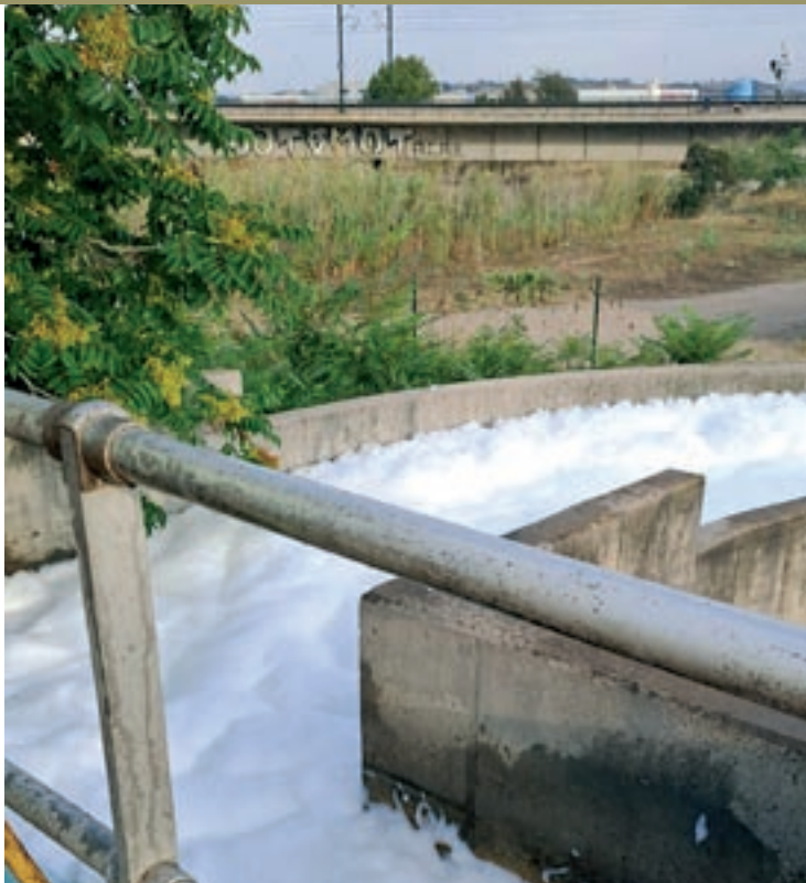
Escuma al canal d'entrada de l'aigua residual a l'EDAR durant el sinistre
