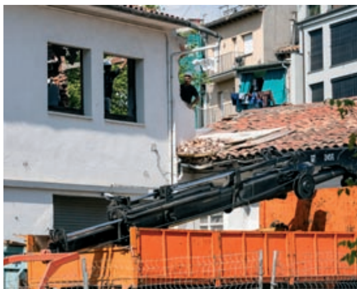
Operaris treballant a la part de l'edifici que ha d'anar a terra
