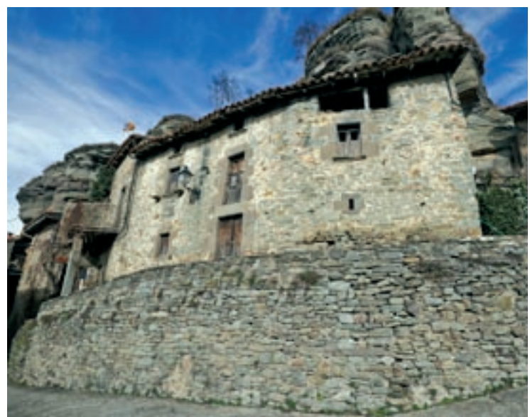
Can Saltiri és un edifici d'interès tipològic, arquitectònic i històric
