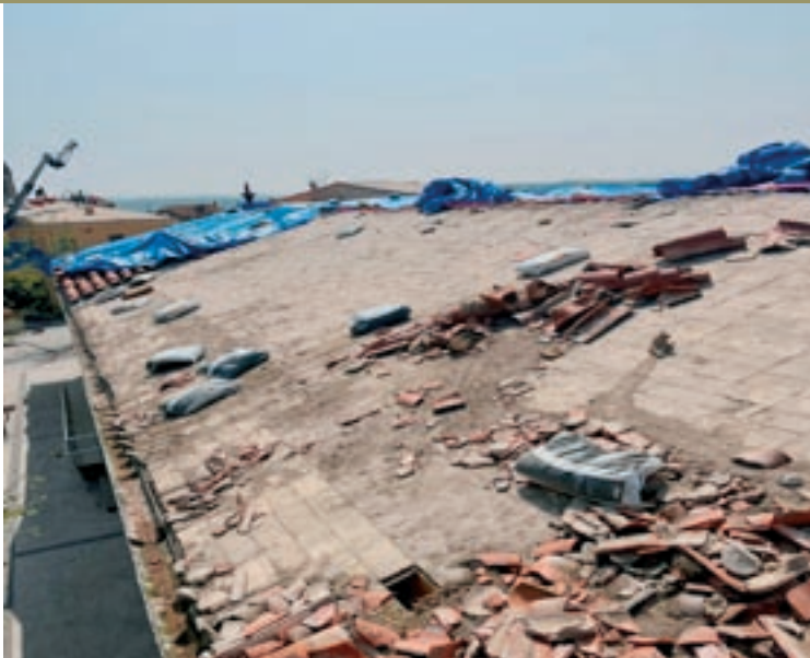
Operaris inspeccionen des d'una grua l'estat de la teulada de l'institut escola Josep M. Xandri. A la dreta, un detall de la teulada, amb les teules retirades
