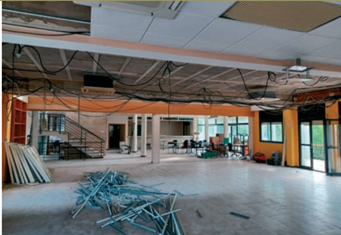
El sostre fals de la planta baixa, desmantellat durant l'inici de les obres
