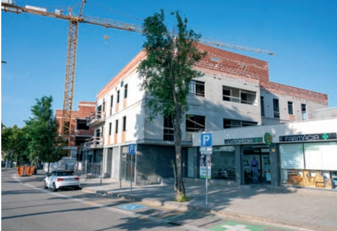
Estat actual de la construcció dels habitatges de protecció oficial de la plaça dels Països Catalans
