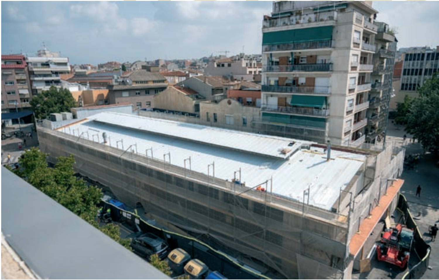
Aspecte actual del mercat de Sant Carles, amb bastides a les façanes
