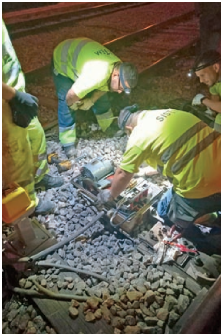
Treballadors reparant els canvis d'agulla de Montcada aquest juny
