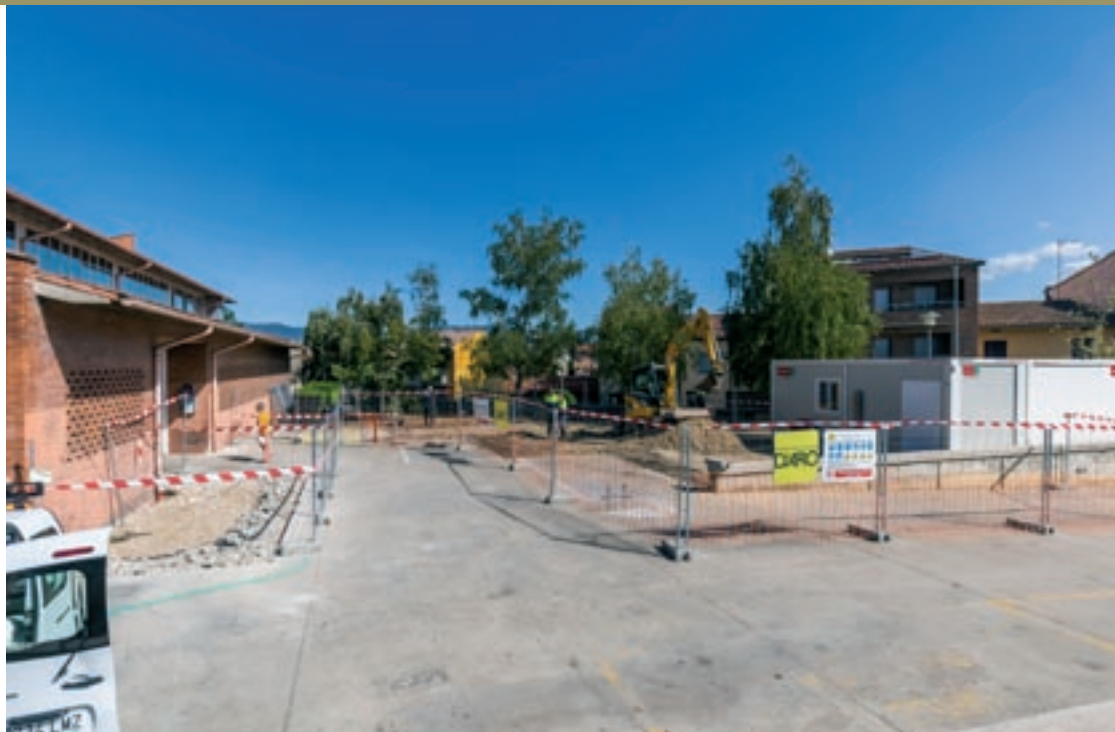
Vista de les obres en curs al CAP de Manlleu, abans de començar a fer els fonaments per als mòduls
