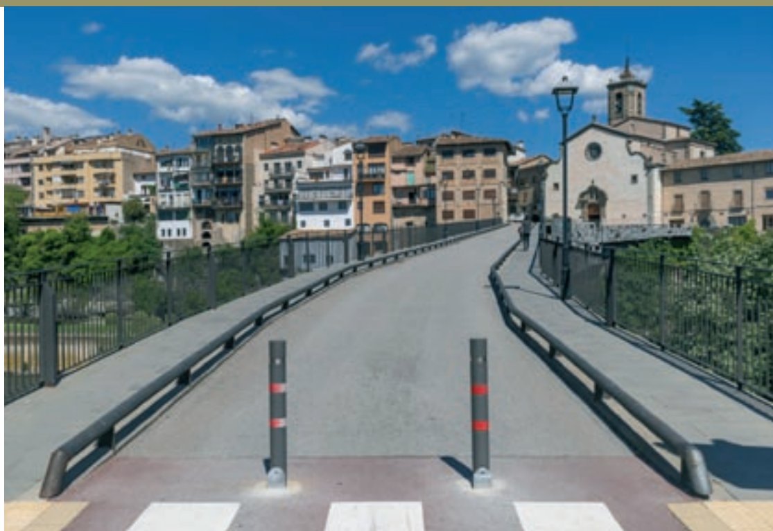
El Pont Vell de Roda de Ter, tallat al trànsit de vehicles, en una imatge de començament d'estiu
