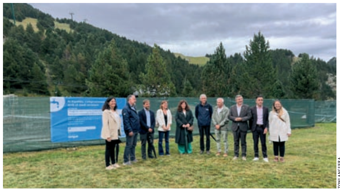
A dalt, la consellera Sílvia Paneque amb l'arquebisbe Joan-Enric Vives. A baix, la visita a les obres de la depuradora
