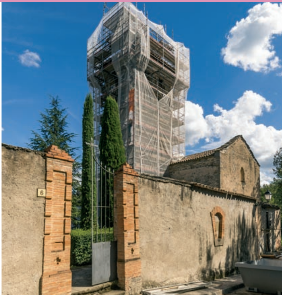
Aspecte actual de l'església i el campanar de Sant Martí Sescorts, amb la bastida de les obres
