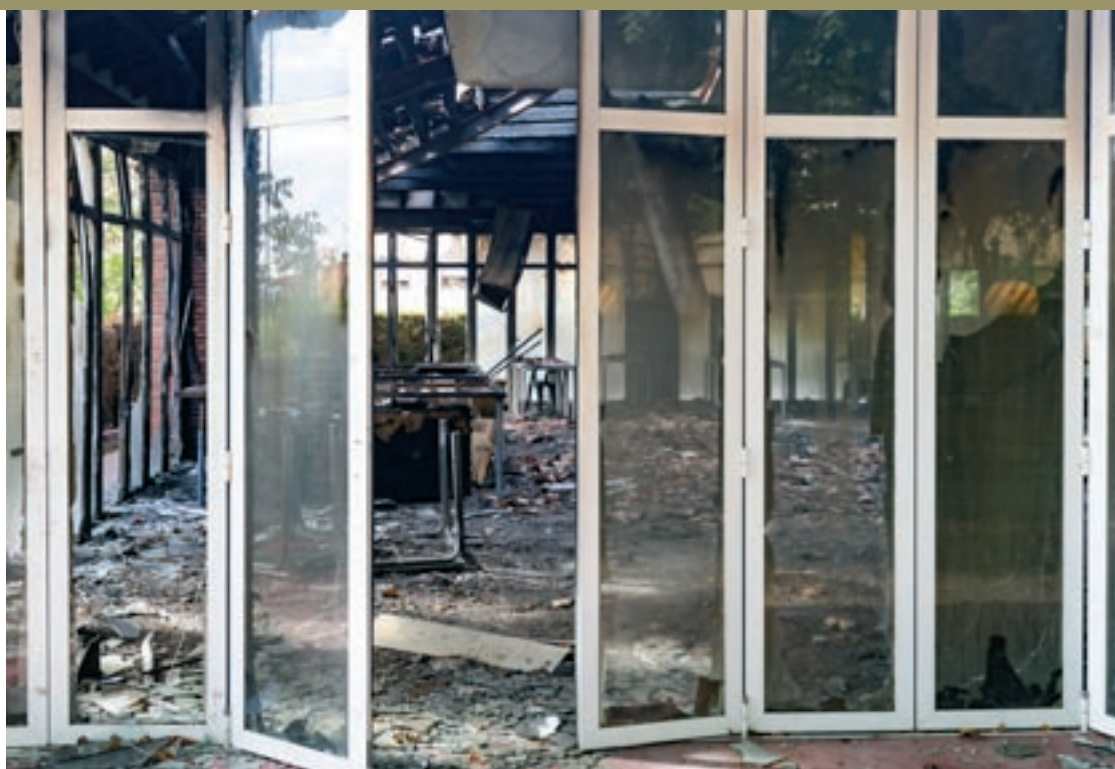
Aspecte de la porxada, aquest dijous a la tarda
