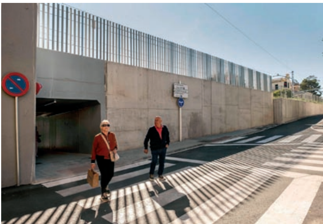
El mur de formigó a la ronda del Carril, a l'altura del nou pas inferior, al passeig Ignasi Sala
