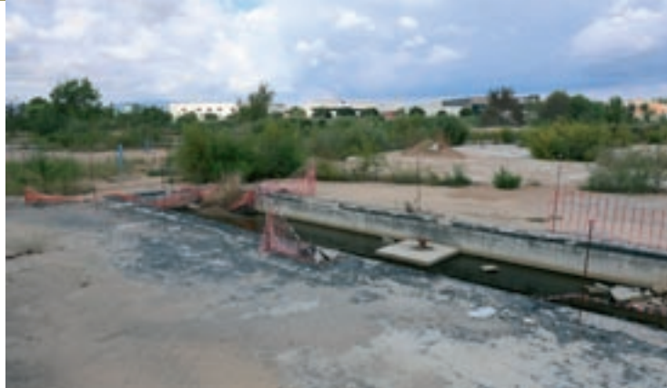
La parcel·la industrial que havia ocupat Ditecsa, a Montornès, aquest dijous
