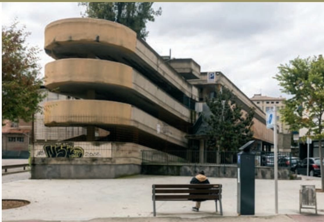
Estat actual del mercat, aquest cap de setmana, just abans que sigui aterrat
