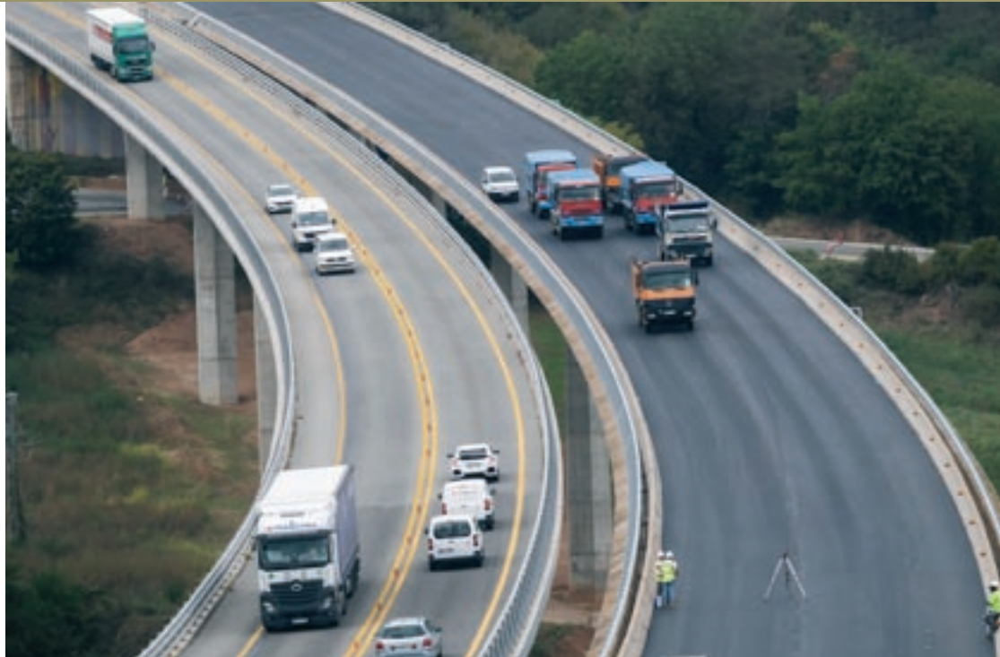
Els camions circulant per sobre un dels dos ponts del viaducte de Sant Sadurní, tallat des de finals de l'any passat
