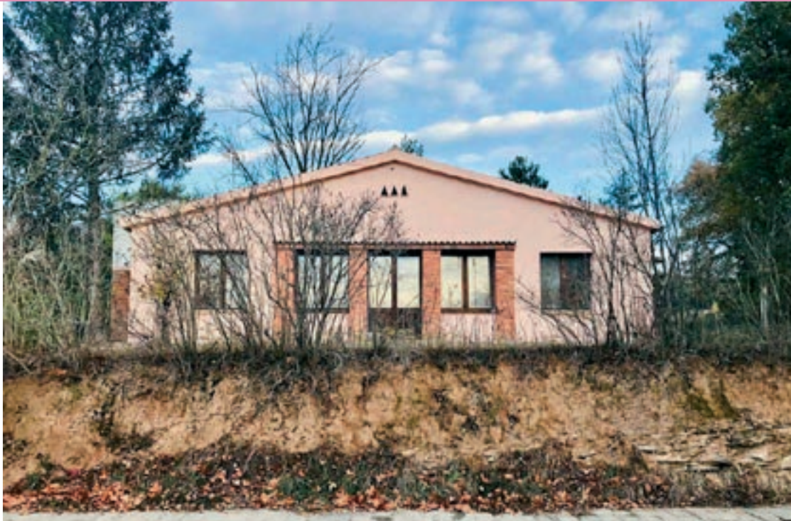
Una vista exterior de l'edifici
