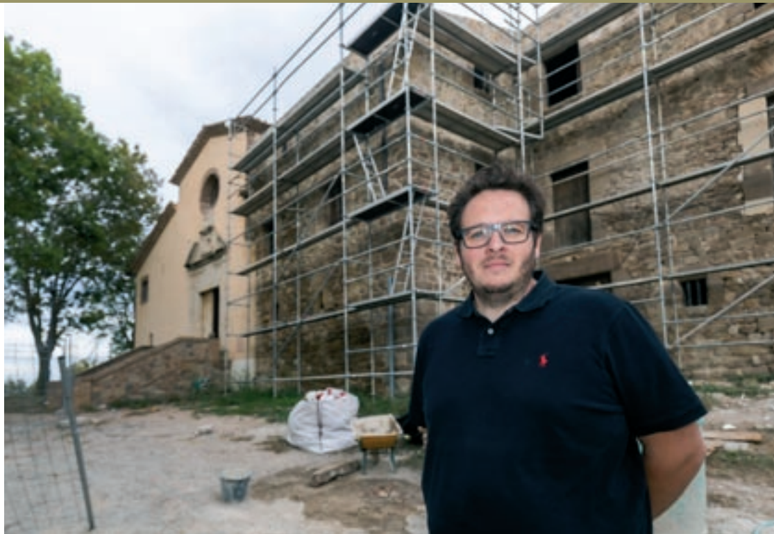
Morera, la setmana passada davant les obres de la rectoria de Sant Quirze i Santa Julita
