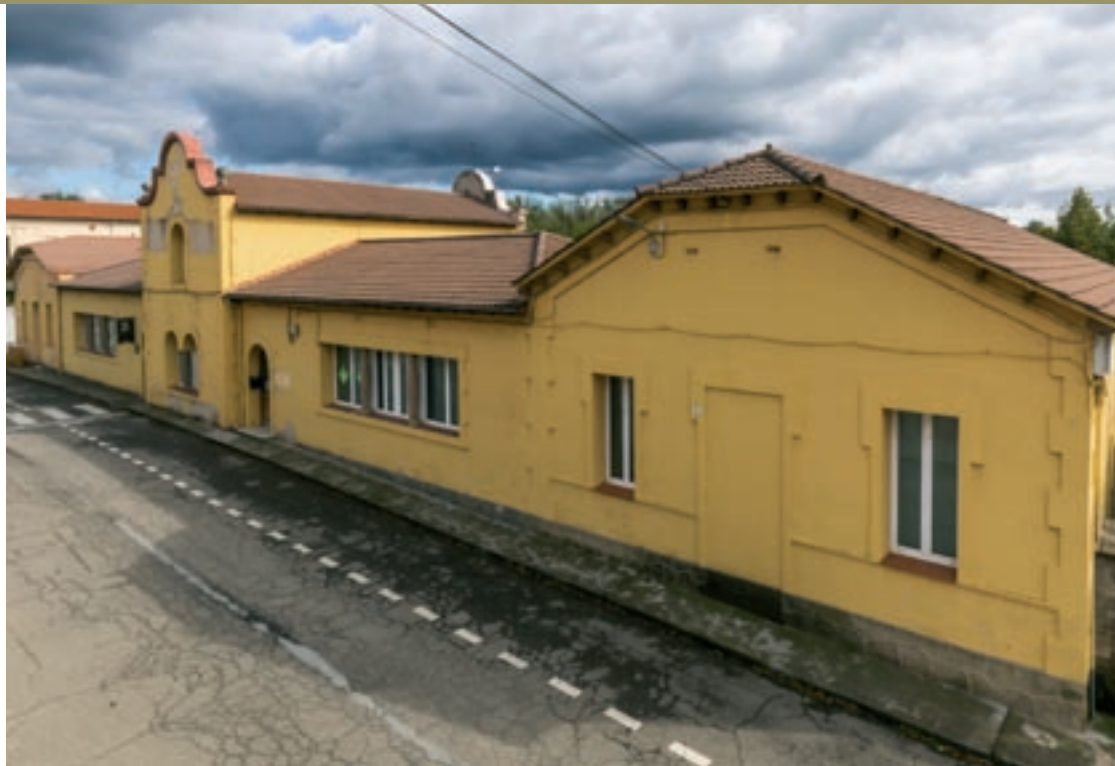
En primer terme, els tres mòduls dels cinc de l'edifici de les antigues escoles on han d'anar els pisos
