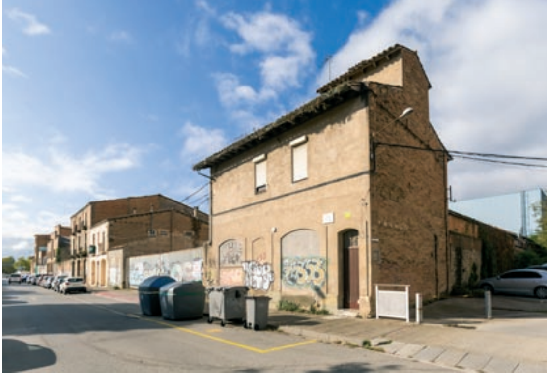
El refugi està ubicat al solar que hi ha entre el carrer de Joan de Serrallonga i el de Perot Rocaguinarda de Vic
