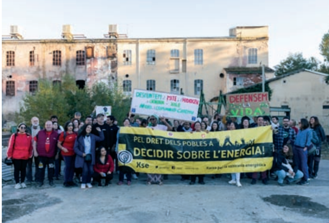
La seixantena d'activistes del Volt 6, davant de la central hidroelèctrica de Can Trinxet
