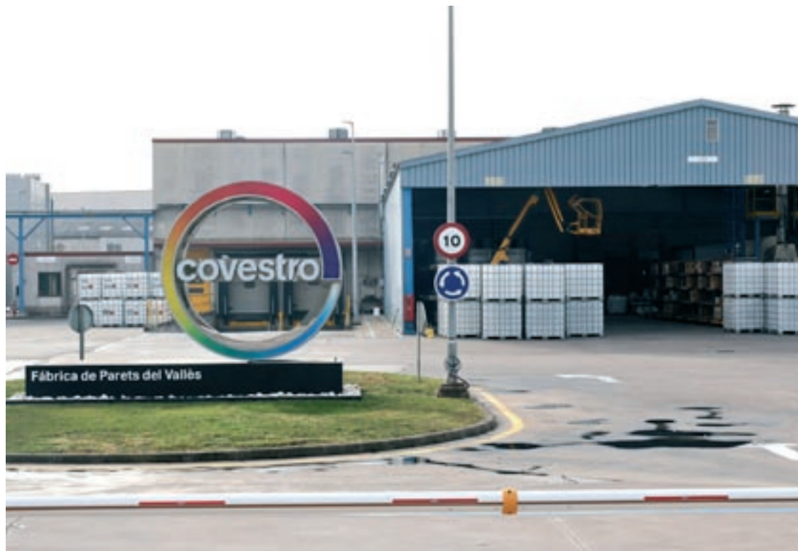
Accés a la planta de Covestro al polígon industrial Llevant de Parets
