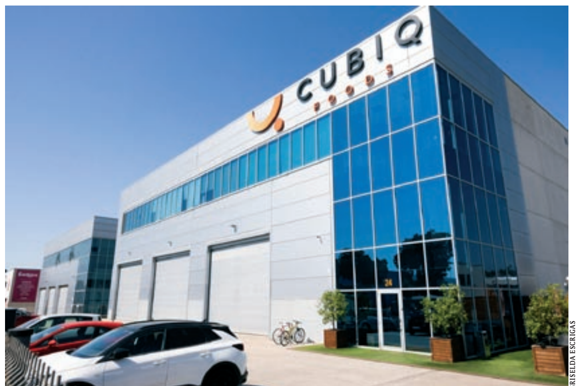
Instal·lacions de Cubiq Foods al polígon de Palou Nord de Granollers
