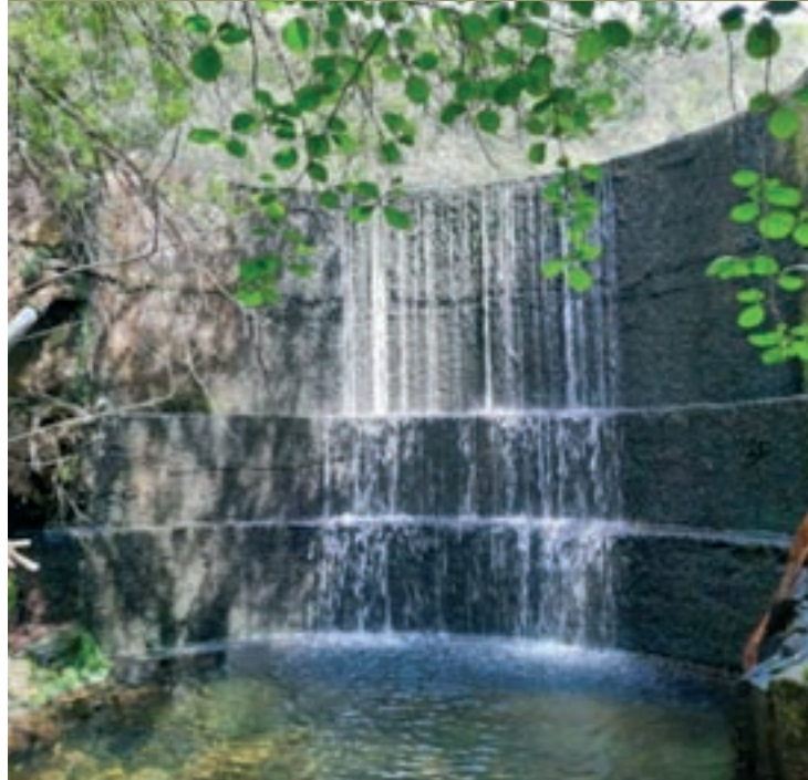
La resclosa del pantà de la font del Vern fa 4,5 metres d'alt i 19 de llarg
