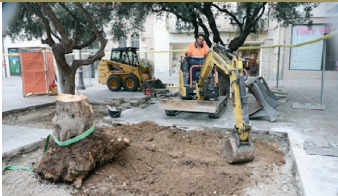
La soca tallada de l'olivera de la Porxada aquest dimarts en els treballs que s'estan fent per millorar l'espai
