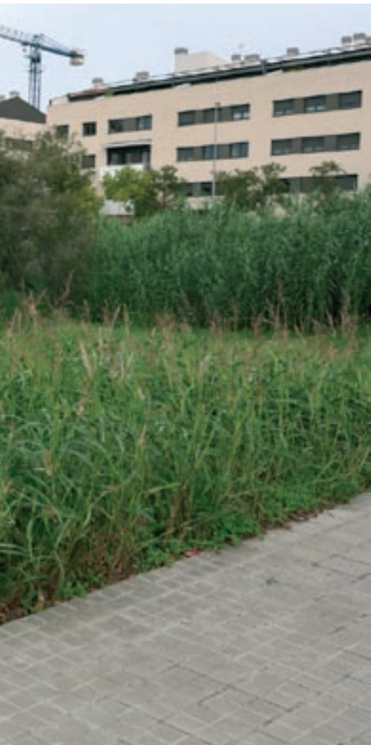
Construcció de 57 habitatges de lloguer social
