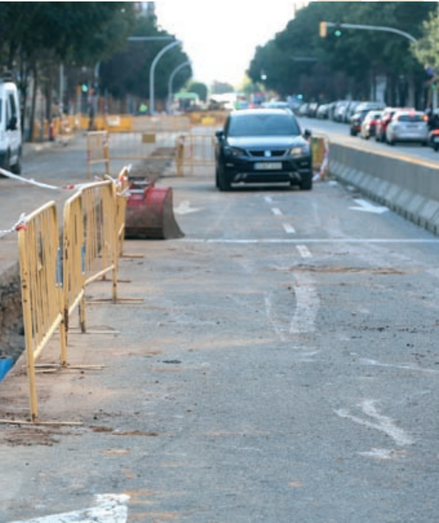
La obra que Agbar està fent a l'avinguda Sant Esteve, a Granollers
