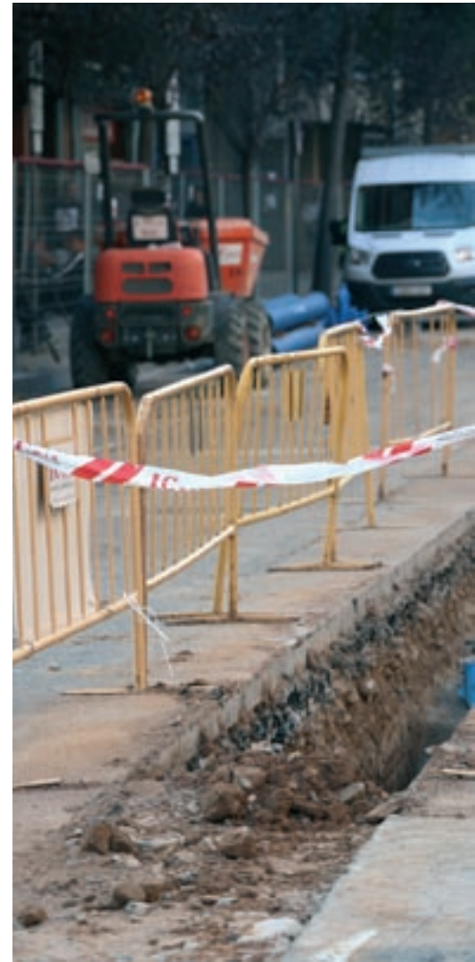
Els treballs de construcció de la nova canalització d'aigua
