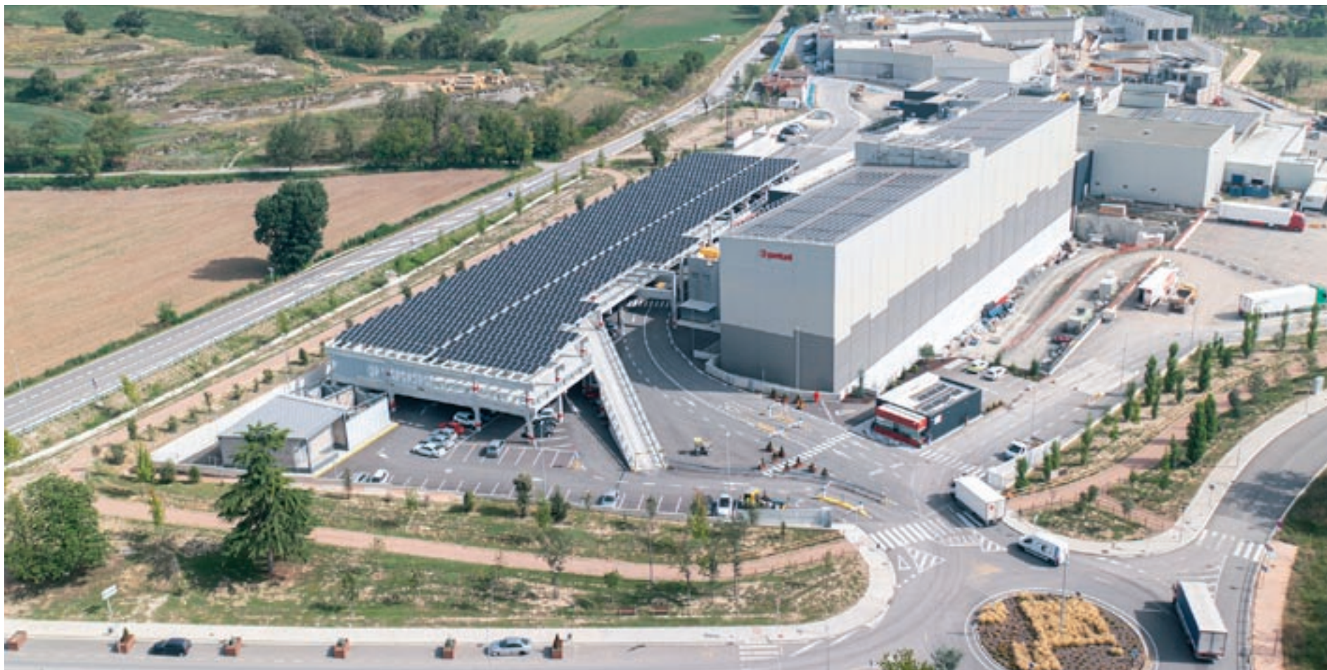
Instal·lacions de Patel - Grup Vall Companys i de les seves plaques fotovoltaïques
