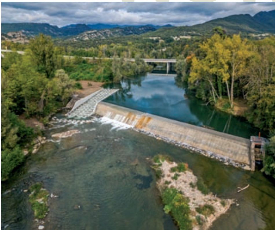
A l'esquerra, l'assut del Molí, a Orís, vist des de l'aire, i a la dreta, la rampa de peixos de curs ascendent
