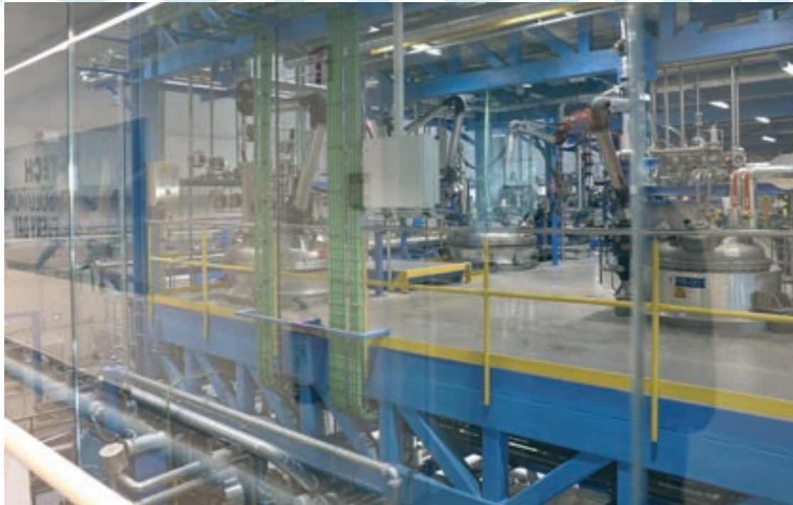
Interior de la planta d'adhesius de Henkel, una de les principals multinacionals a la comarca, a Montornès
