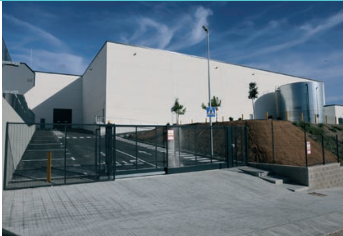
Les naus que s'han acabat de construir i que ara es comercialitzaran a través de les immobiliàries Forcadell i CBRE
