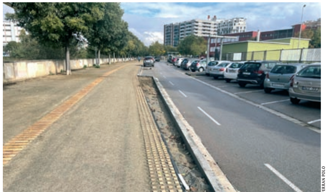
La nova configuració del tram nord del passeig Fluvial amb la vorera ampliada amb sauló i un sol carril de circulació
