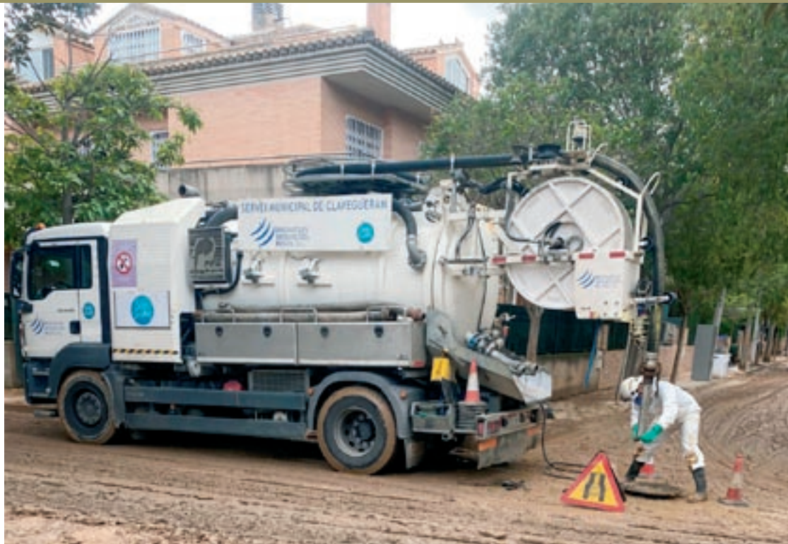
Operaris de Drenatges Urbans del Besòs treballant aquests darrers dies en el claveguera a pobles afectats per la DANA
