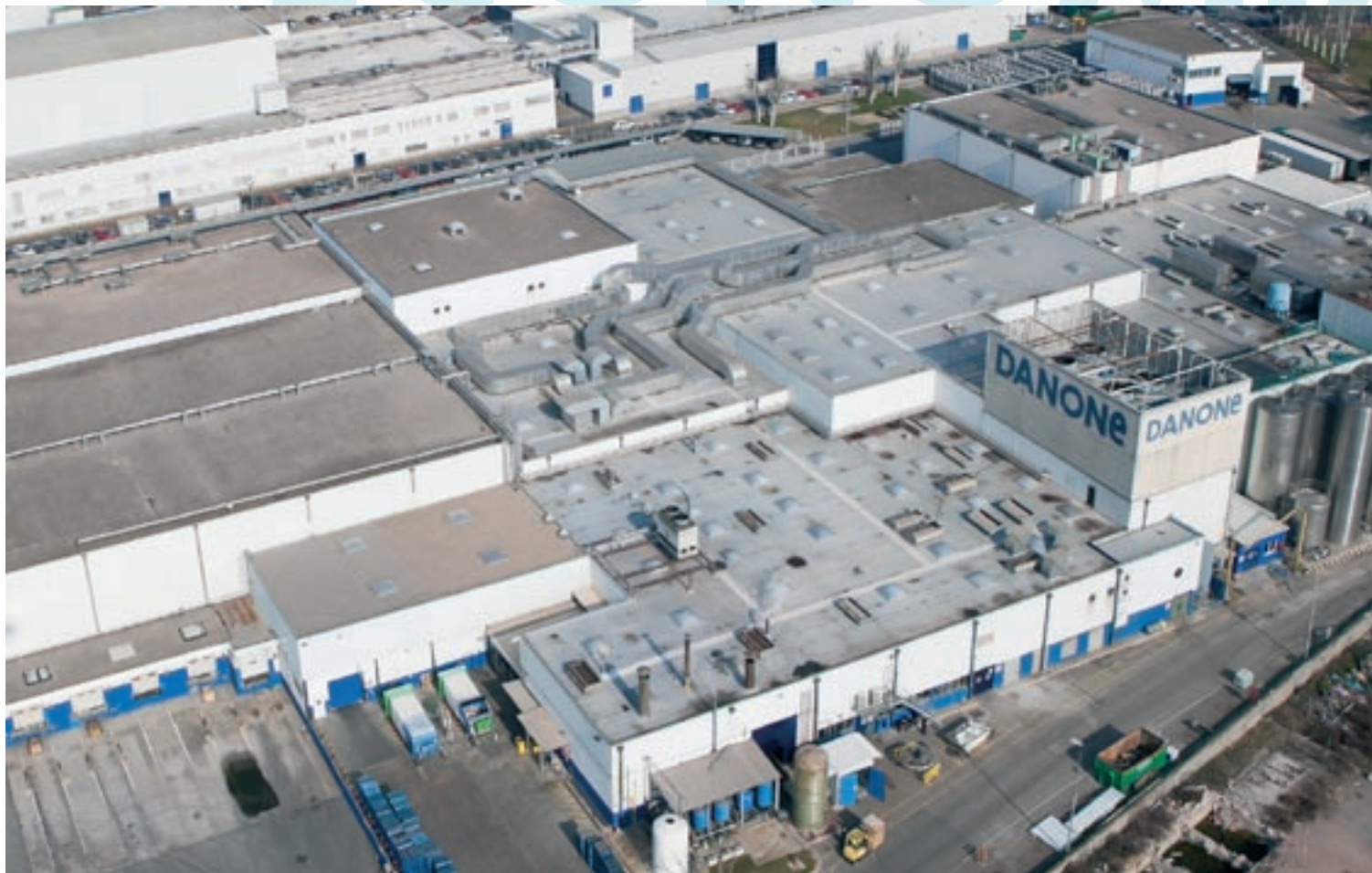
Imatge aèria de la planta de Danone a Parets, edificada sobre un solar amb 51.000 metres quadrats de superfície
