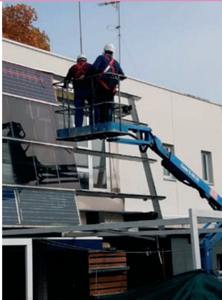
Els operaris durant la retirada de les plaques de l'escola bressol El Blauet
