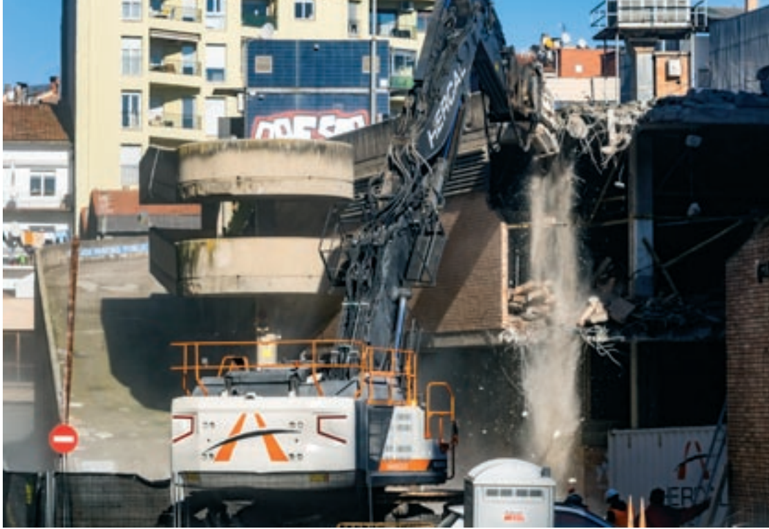
La grua en plena demolició, divendres al migdia
