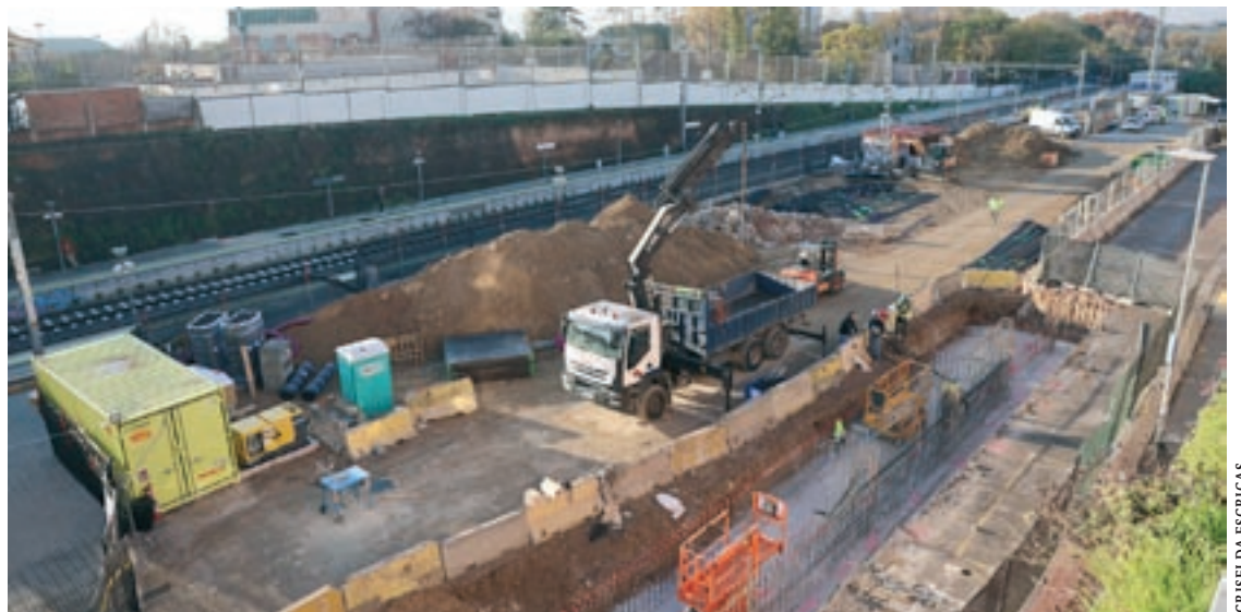
Obres a l'entorn de l'estació de tren de Parets per cobrir un tram de les vies de l'R3 i fer una nova estació
